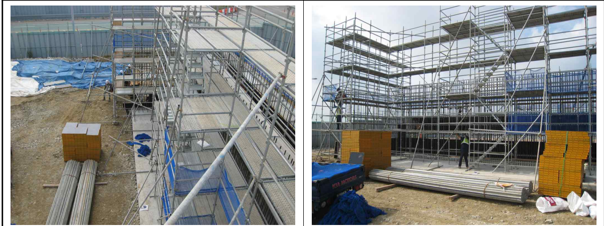
교량 A2 시스템동바리 설치
