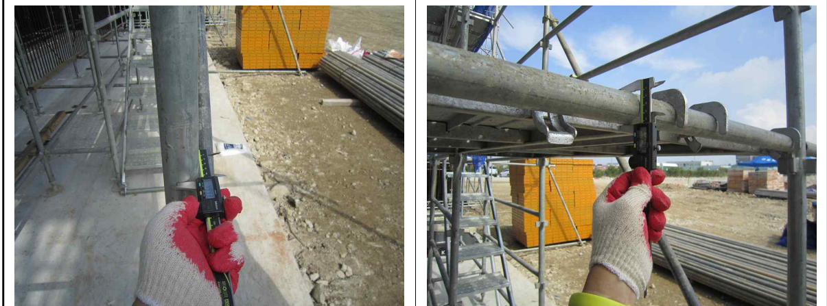
교량 A2 시스템동바리 수직재 및 수평재 직경측정 현황
