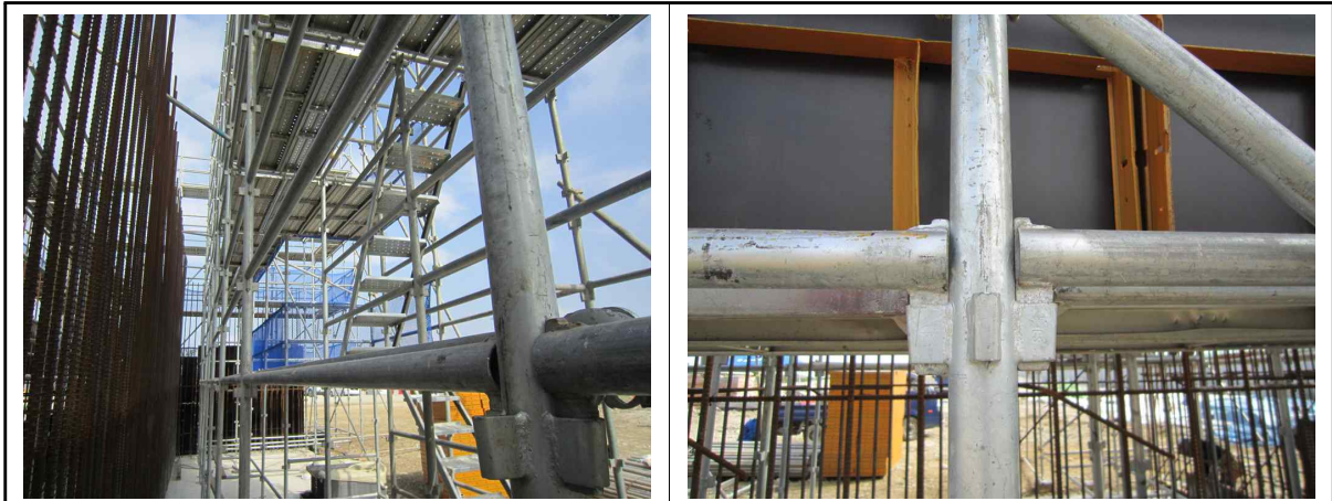
교량 A2 시스템동바리 수직재, 수평재 체결상태 현황
