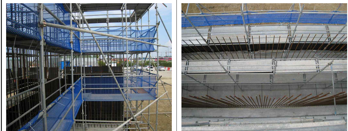
교량 A2 시스템동바리 설치 현황
