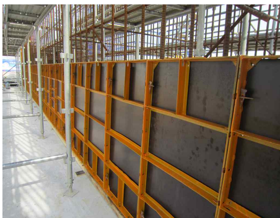
교량 A2 거푸집 설치 상태 현황
