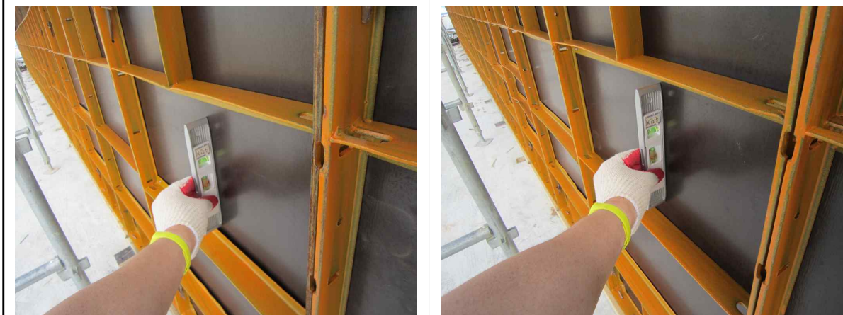
교량 A2 거푸집 수직도 측정 현황
