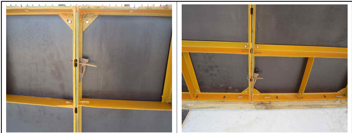
교량 A2 거푸집 체결 상태 현황
