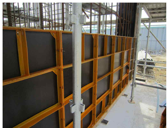
교량 A2 거푸집 설치 상태 현황
