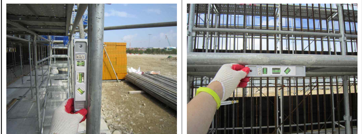
교량 A2 시스템동바리 수직재 및 수평재 수직, 수평도 측정 현황
