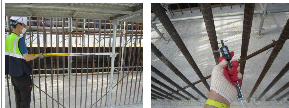
교량 A2 철근 배근 현황
